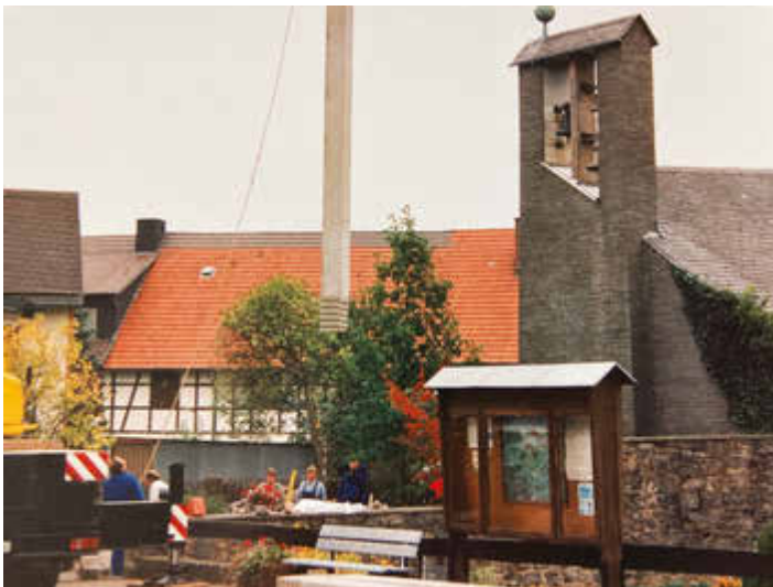
1997/1998 Bau des Glockenturms
